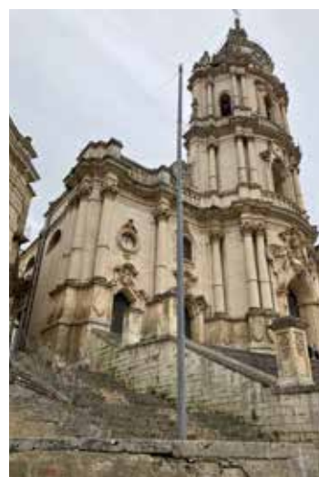
Sv. Džordžo baznīca pašā klints galā.
